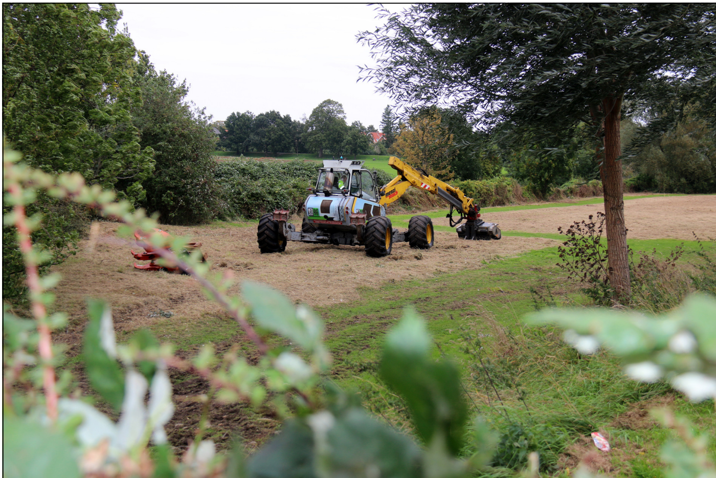
Den godt og vel 12 tons tunge terrængående gravemaskine har en stor rækkevidde på 8,8 meter til siden og 10 meter i højden.
